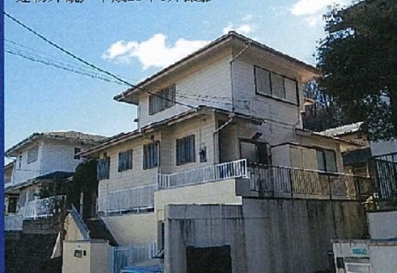
建物外観／平成29年1月撮影
